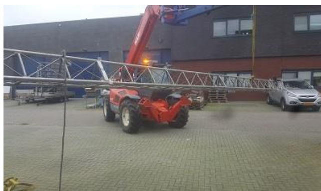
Het gereviseerde topdeel, klaar om op zijn plek gehesen te worden
