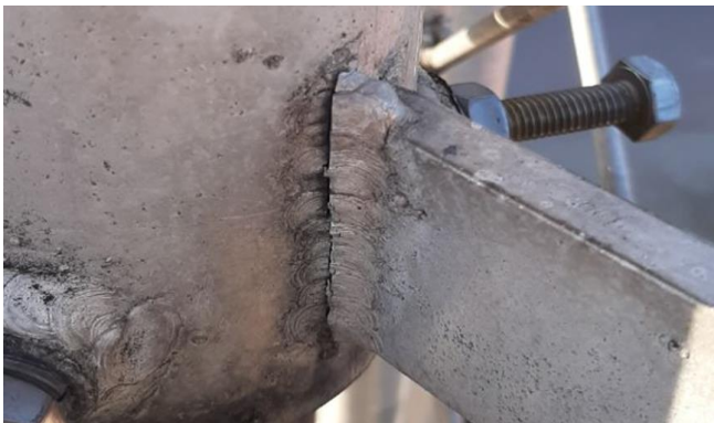
Een aantal lassen waren gescheurd en moesten hersteld worden.
