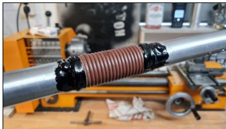
Waterdicht maken met dak reparatie pasta
