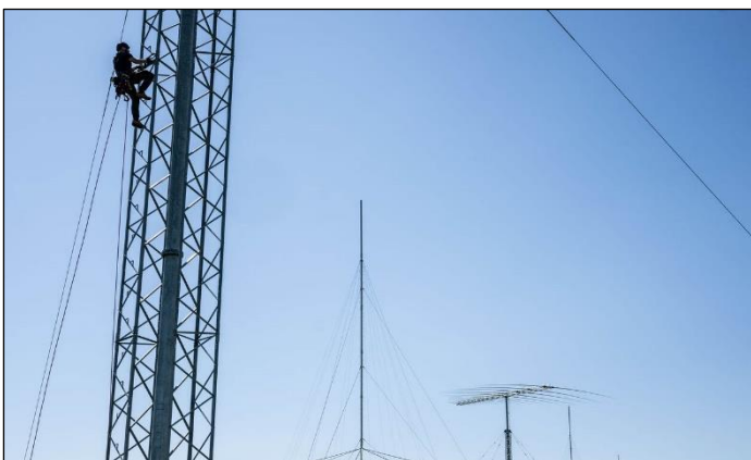
Onderhoud aan antennemasten op grote hoogte.
