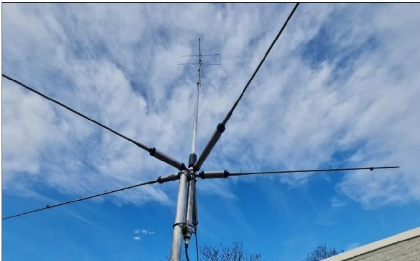
De gerepareerde antenne, alleen nog even de radialen afstemmen
